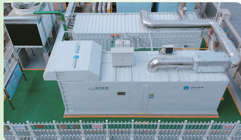
▲ 煤氣公司一直致力推動能源技術創新。深燃大廈綜合能源項目是集團屬下港華能源第一個以燃氣分布式能源為主，綜合光伏及儲能，提供多能源穩定安全供應的「源網荷儲」一體化能源互聯網示範項目。
